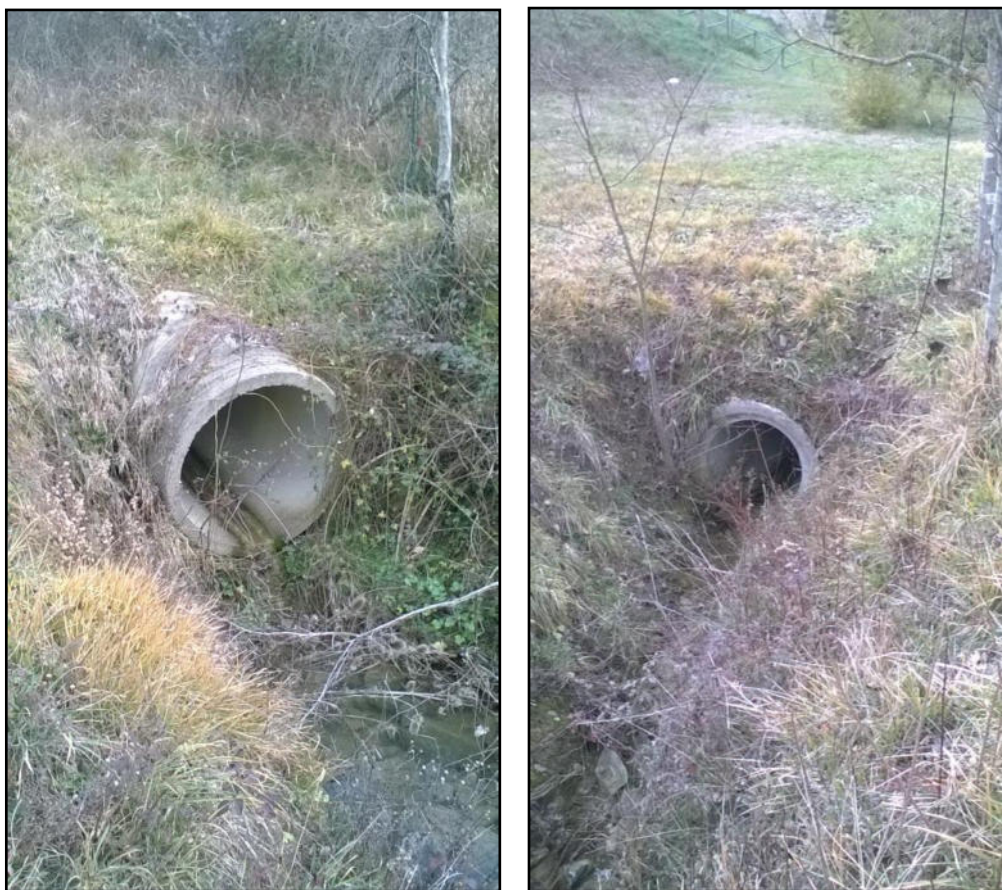
Fig. 27: punto di uscita sul primo tratto tombato (immagine di sinistra) e punto di entrata del tratto finale prima della congiunzione con il fosso Selciaie (immagine di destra del fosso Canapino)
