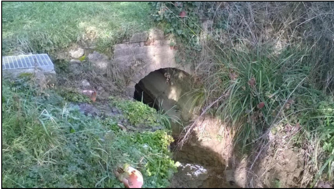
Fig. 22: sezione di uscita della tubazione del 3° tombino a valle del centro storico di Petroio.
