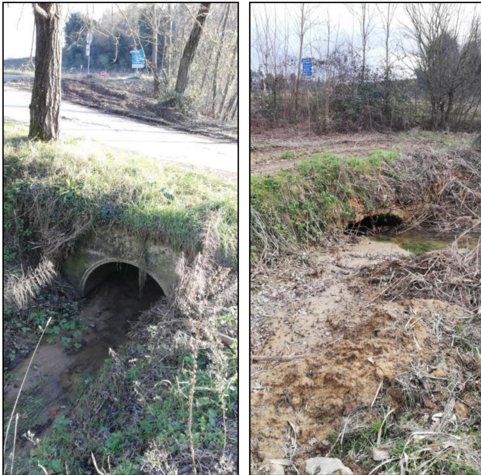
Fig. 4: particolari dell'attraversamento n.2 attuale sul T. Rigo (foto di sinistra) e dell'attraversamento più antico divenuto obsoleto ed ostruito (foto di destra)
