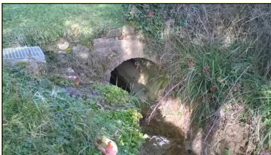
Sezione di uscita della tubazione del 3° tombino a valle del centro storico di Petroio.
