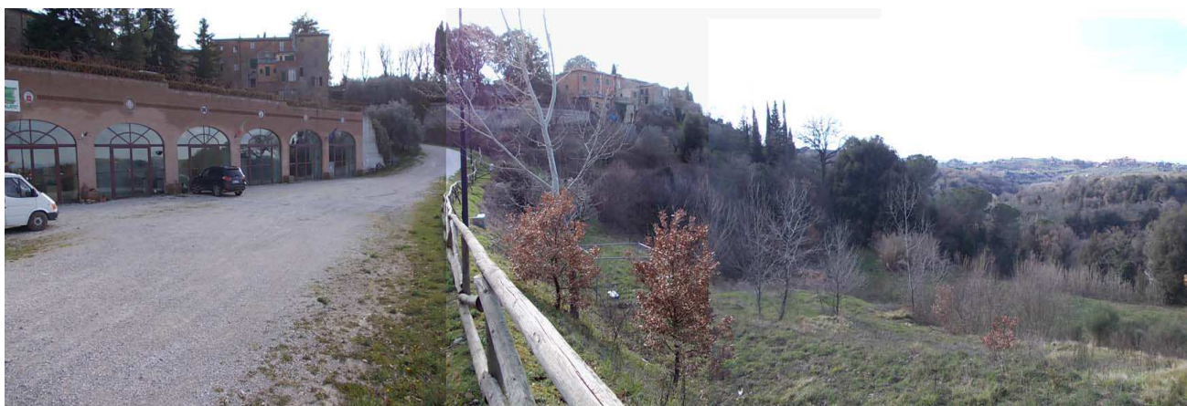
Foto 2 - Veduta dell'area dall'angolo di destra della viabilità di servizio del "Centro dell'Olio"
