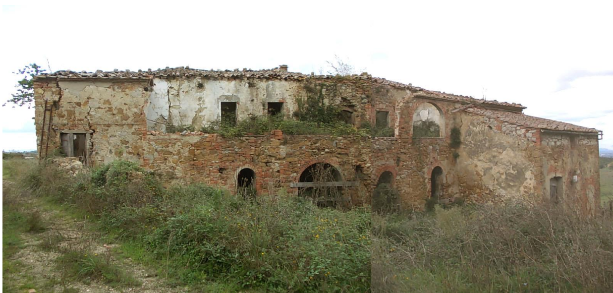
2. Foto del prospetto principale, dalla quale emerge la gravità delle condizioni statiche dell'edificio La loggia a cinque campate originariamente presente al primo piano è completamente crollata
